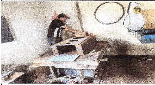
Foto1: Sustitucion de estufa rural (completa) incluye chimenea y plancha de metal
