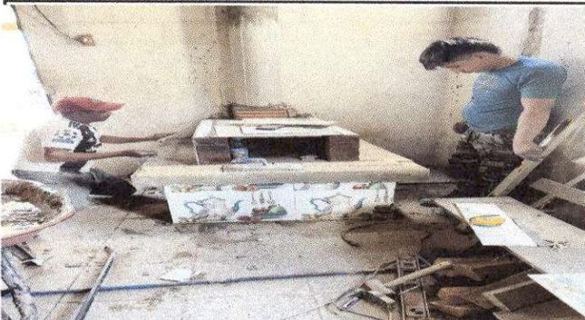
Foto 3: Sustitucion de estufa rural (completa) incluye chimenea y plancha de metal
