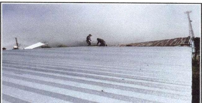
Foto 6: Techado de Lamina troquelada calibre 26 aluzinc
