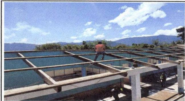
Foto 3: Reparacion de reglas y tendales para la sustitución de lámina por lamina troquelada
