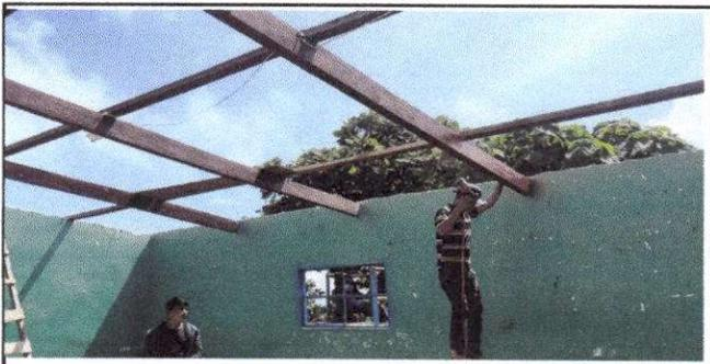
Foto 5: Pintando reglas y tendales para la sustitución de lómina por lámina troquelada
